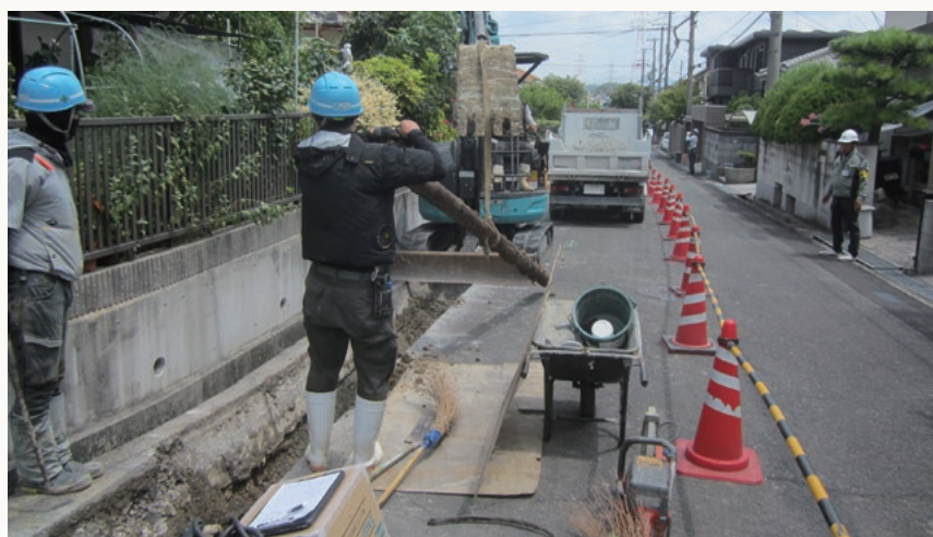
(管の更新工事のようす)
