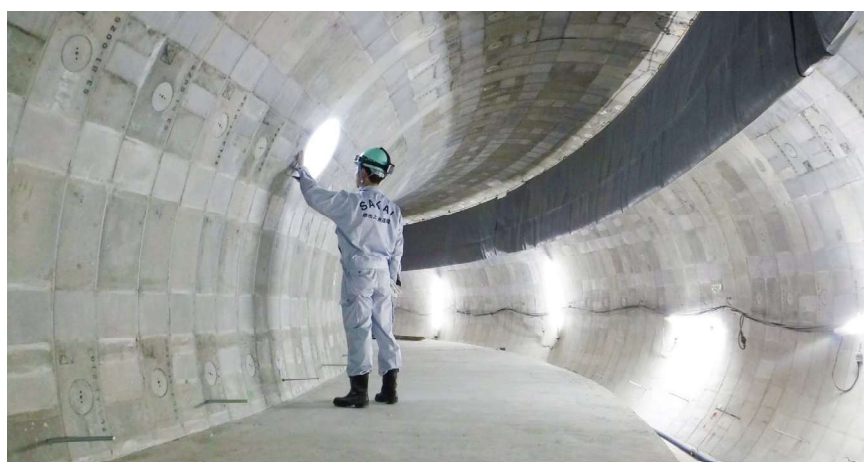
▲実際の下水道管の内部
