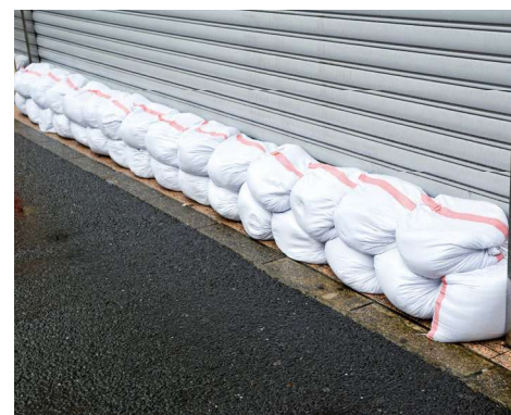
▲土のうを積み上げた様子
