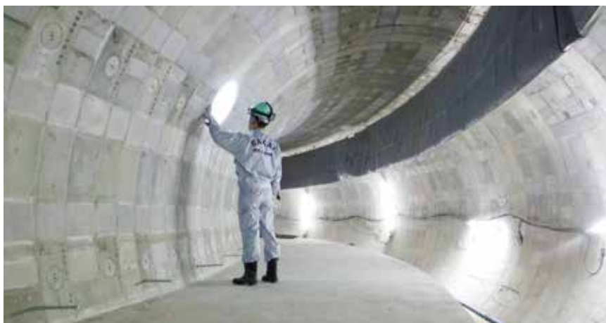
▲実際の下水道管の内部
