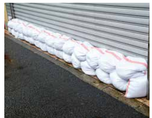
▲土のうを積み上げた様子
