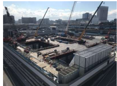
（令和 4 年 2 月の工事写真）
