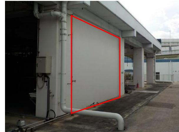
「耐震壁の設置」による耐震化
