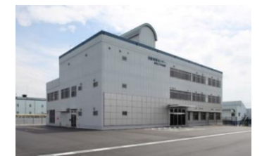
災害対策センター (下水道管路調査支援都市の集積基地)
