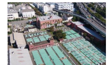
③水再生センター施設維持管理業務（運転監視・保守点検等）
