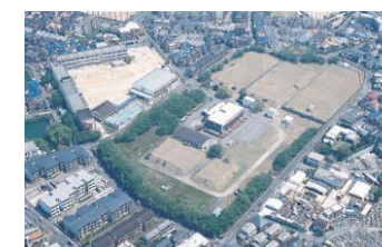
家原寺配水場 (応急給水の本部)
