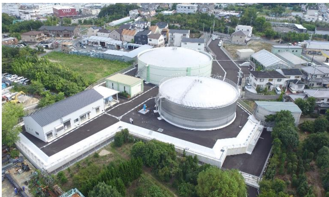
管生配水池 3,500m 3 ステンレス製新配水池 (右下)
