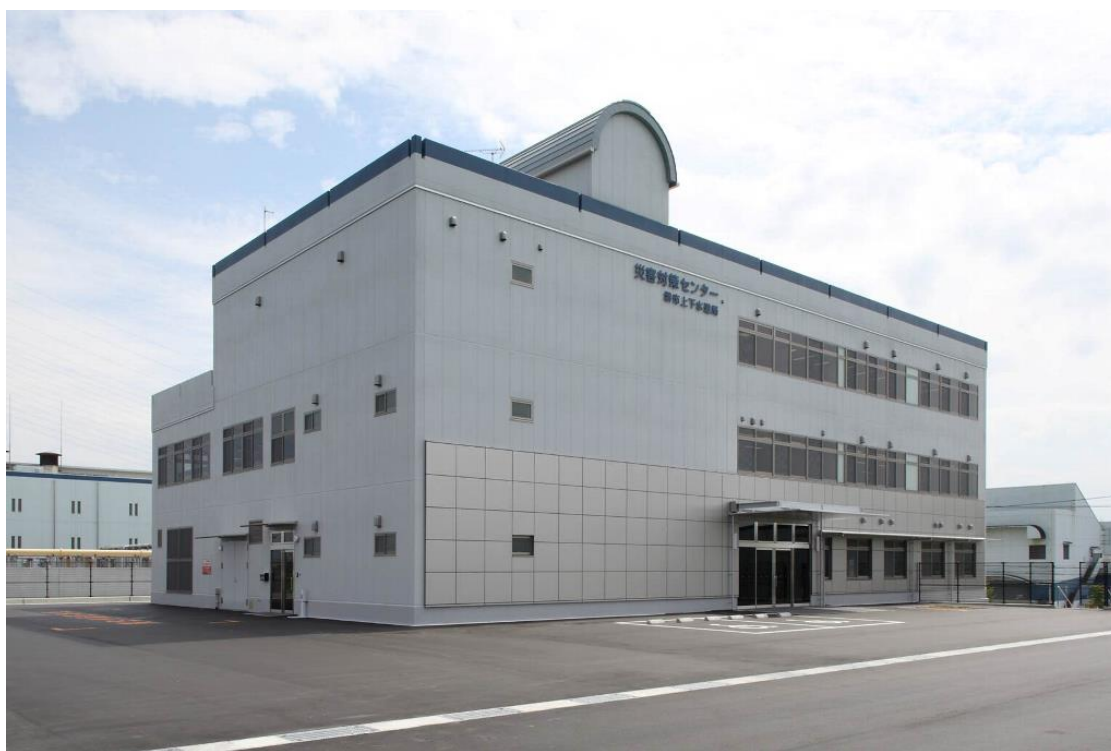
災害対策センター
