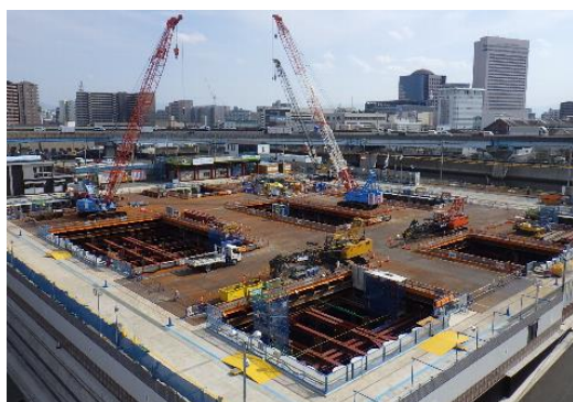
古川下水ポンプ場施工状況
