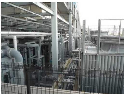
下水再生水熱利用システム
