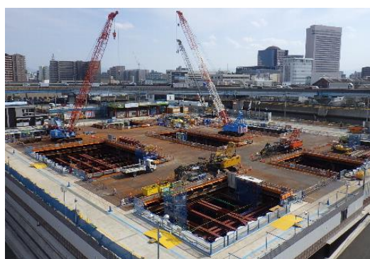
古川下水ポンプ場施工状況
