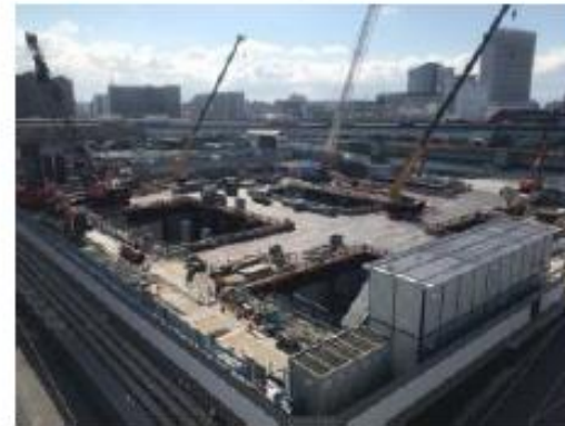
（令和 4 年 2 月の工事写真）
