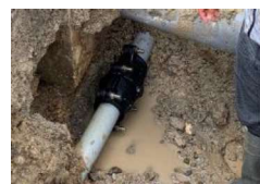
地下漏水の修繕後
