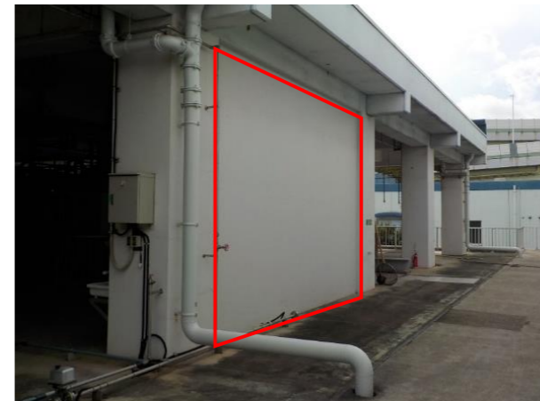
「耐震壁の設置」による耐震化
