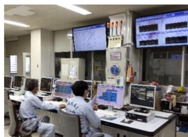
【水再生センターの運転監視】
