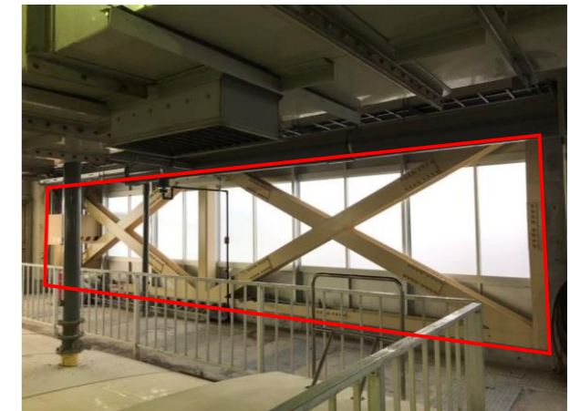
「ブレース※の設置」による耐震化
