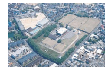
家原寺配水場 (応急給水の本部)
