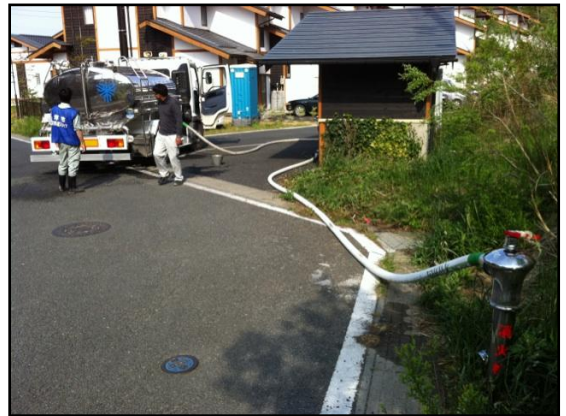
給水タンク車への水補給の様子 陸前高田市仮庁舎横に設置された地上式消火栓から水を補給しています。
