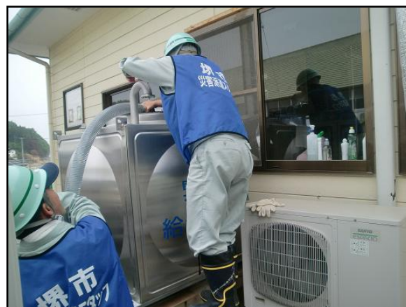
広田保育園受水槽への給水作業
