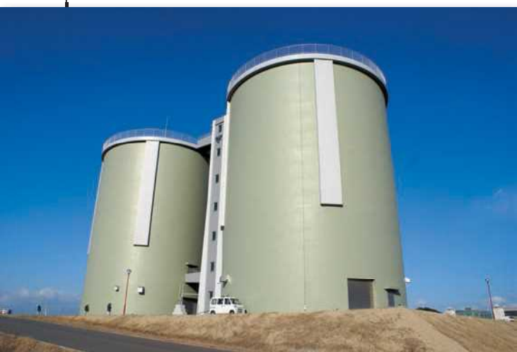
あさか やまはいすいじょう 浅香山配水場
