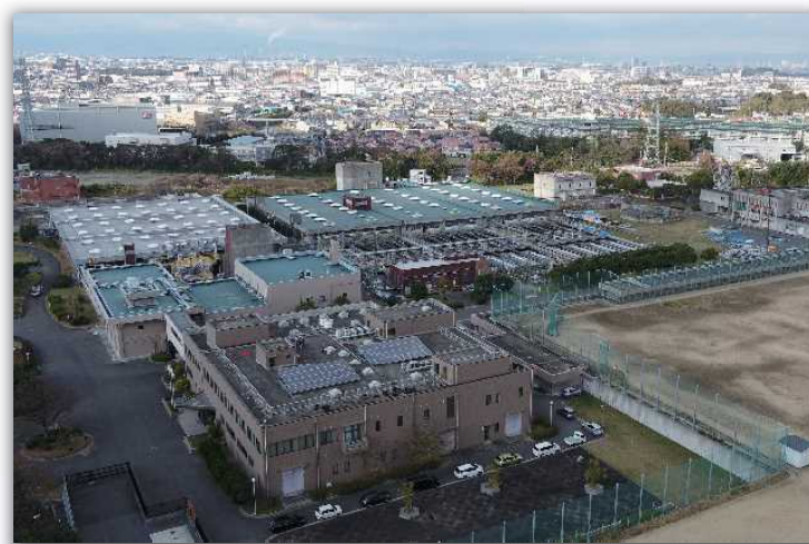
せんぼくみずさいせい 泉北水再生センター
