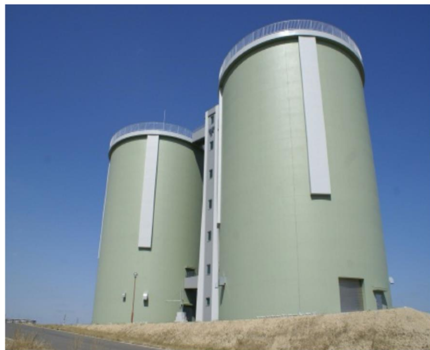
浅香山配水場高架配水池
