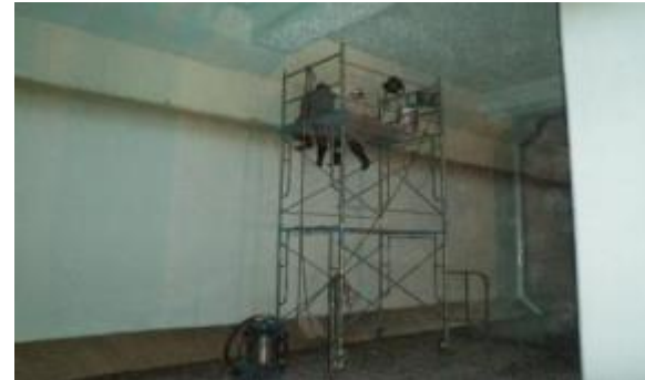
内面劣化調査
