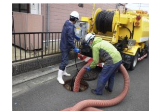
②下水道管路施設維持管理等業務（日常点検・清掃・調査・修繕等）
