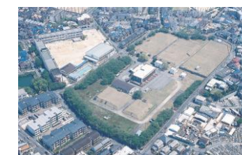
家原寺配水場 (応急給水の本部)
