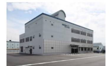
災害対策センター (下水道管路調査支援都市の集積基地)
