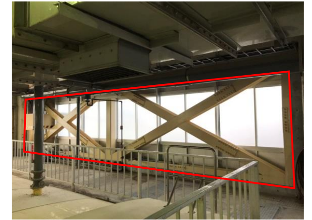
「ブレース※の設置」による耐震化
