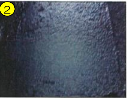
【人孔内部コンクリート表面】
