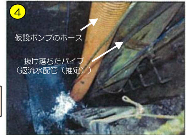
【抜け落ちたパイプ(人孔底付近)】
