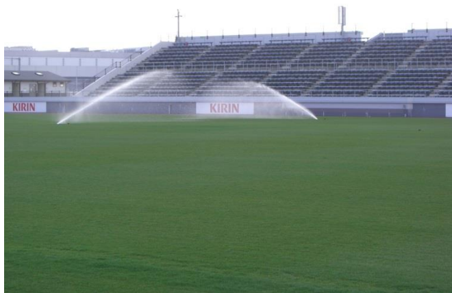
再生水の散水状況（J-Green 堺）
