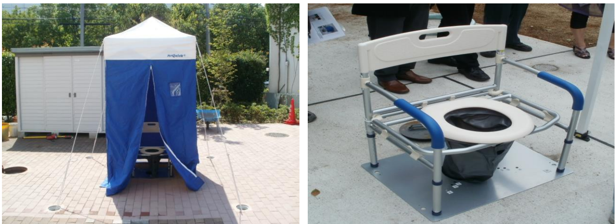
図 マンホールトイレの設置状況
