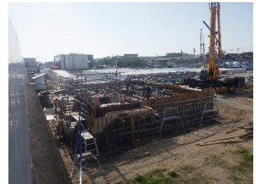
新設次亜塩素棟 施工状況
