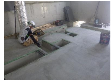
次亜塩素棟 施工状況（屋内左官）
