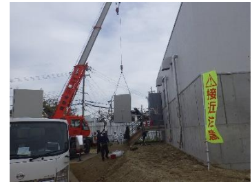
次亜塩素棟 施工状況
