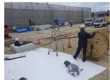
電気設備工事 施工状況
