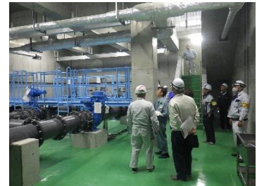
新設次亜塩素棟 立会状況
