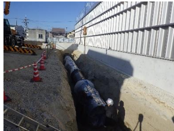
場内配管工事 施工状況
