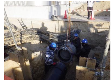
場内配管工事 施工状況
