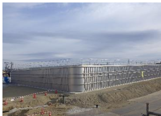
【新設No.2配水池】
