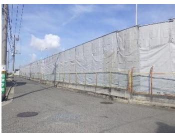
仮設工事 仮囲い設置（配水場東南側）
