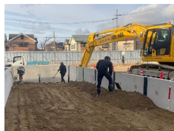
場内整備工事 擁壁工事（埋戻し状況）
