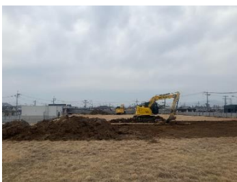
配水池工事 既設構造物撤去（表土除去）
