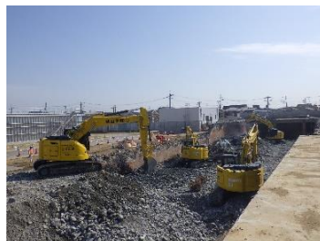
配水池工事 解体作業状況
