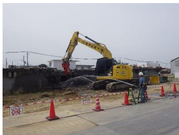
配水池工事 解体作業状況
