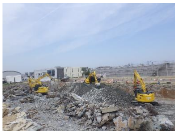
配水池工事 解体作業状況
