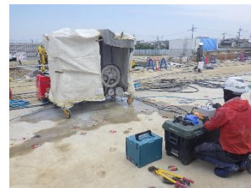
配水池工事 切断撤去作業状況
