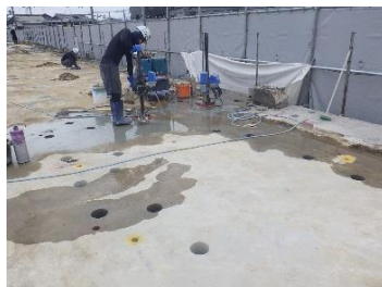
配水池工事 切断撤去作業状況
