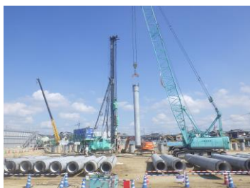
配水池工事 基礎杭打設状況
