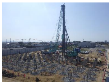
配水池工事 基礎杭打設状況
