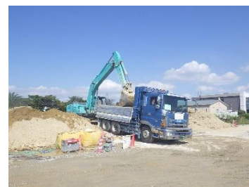
配水池工事 杭残土運搬状況
