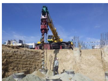
基礎杭工事 杭頭処理状況
