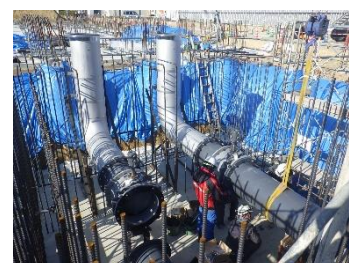
設備工事 弁室配管状況
