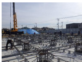
基礎工事 鉄筋加工組立状況
