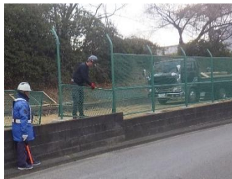
【施工状況写真】
