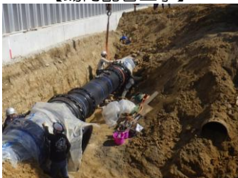
【場内配管工事】
