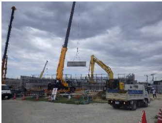
ステンレスタンク タンク組立状況
