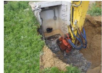
場内整備工事 既設構造物撤去状況
