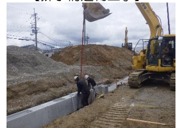
【排水構造物工事】
