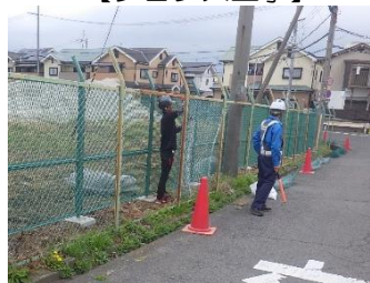
【フェンス工事】
