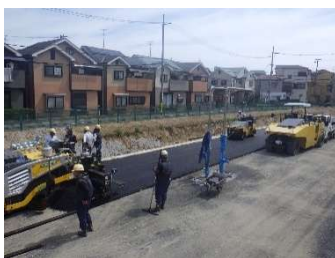
場内整備工事 舗装工事状況
