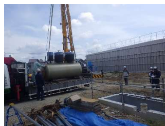
設備工事 地下燃料タンク設置状況
