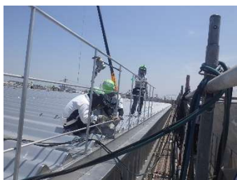
ステンレスタンク タンク組立状況
