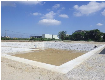
場内整備工事/雨水貯留池
