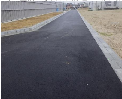
場内整備工事/排水構造物（側溝）
