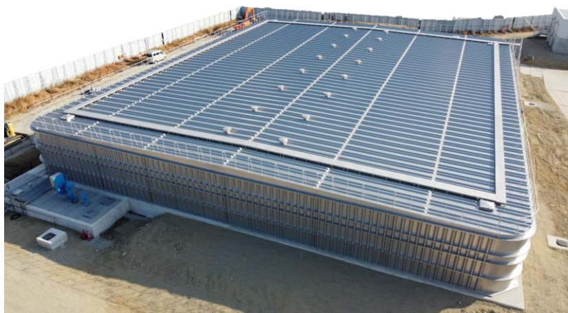
写真：家原寺配水場（新No.2配水池）
