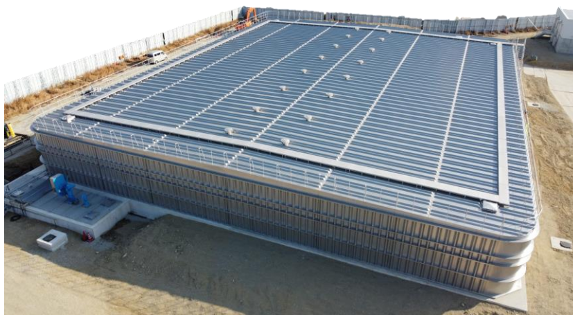
写真：家原寺配水場（新No.2配水池）
