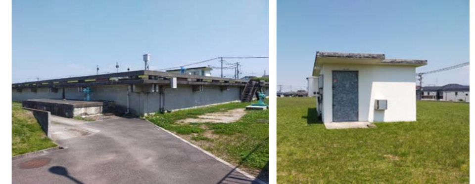
②、③ 既設No.2配水池、既設No.3配水池
